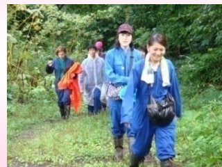
歩道修理作業
