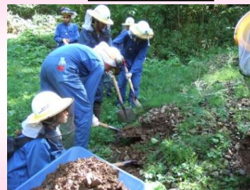
道路維持作業
