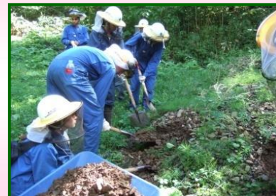
道路維持作業
