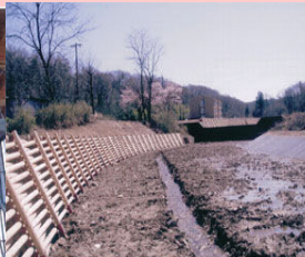
工事に国産材使用
