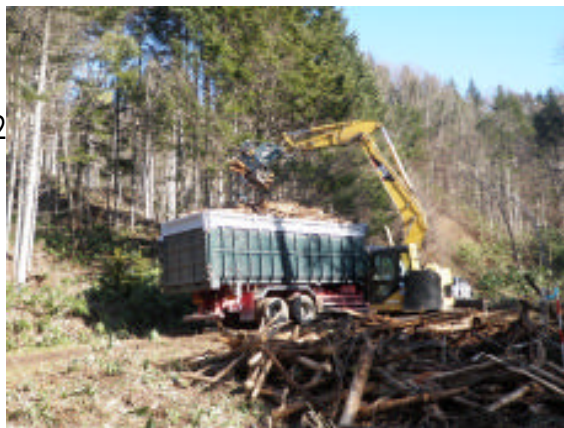
集積後の残材の積み込み状況
