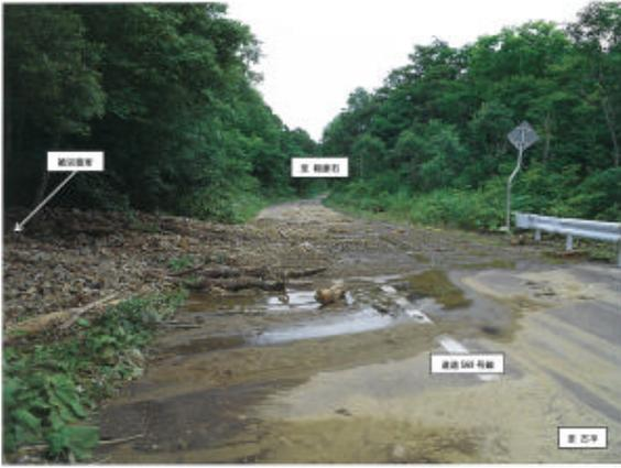
① 保全対象・被災状況：流出土砂による国道569号線の被災状況
