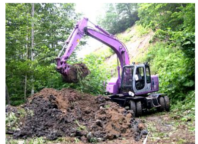
重機を使った林道修理作業
