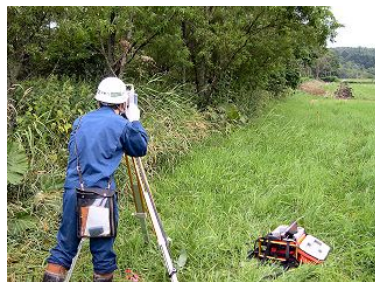
測量機器を使った境界検測作業
