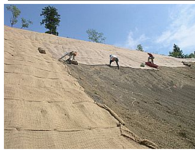
急傾斜地で施工中「植生ネット工」
