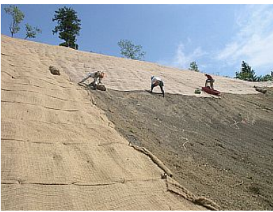
急傾斜地で施工中「植生ネット工」
