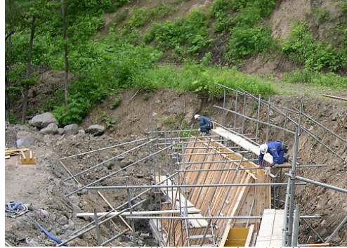
よう壁工を進めている幌別林道
