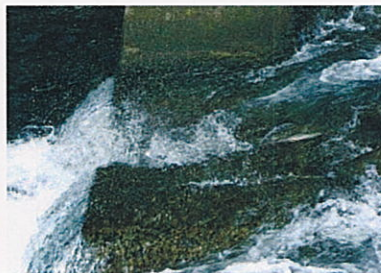
改良後の状況
