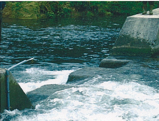
スリットを入れたえん堤
