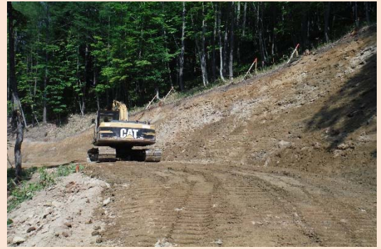
林道工事の様子
