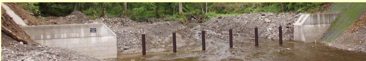
溪床の侵食防止と流木の流出を防ぐ目的で作られた治山ダム
