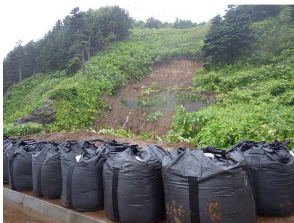
崩落した斜面 (内路地区 R2.8月撮影)
