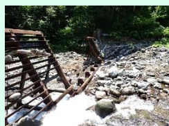
切り下げた鋼製ダム
