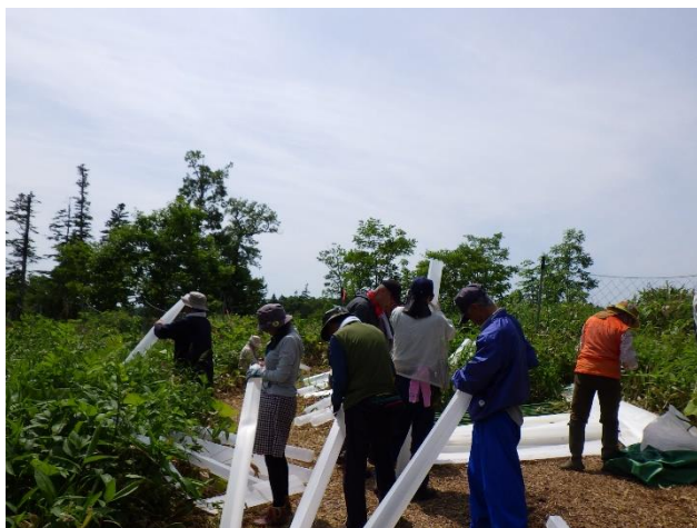
▽保護管を組立てる様子
