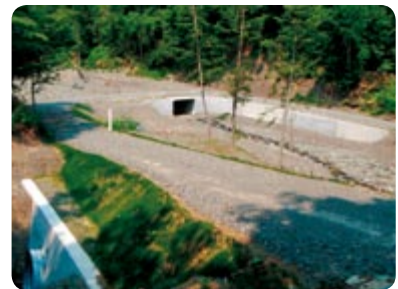
↑林道部門の優良工事で北海道森林管理局長賞を受賞した「三井の沢林道災害復旧工事」
