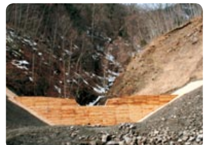
↑治山部門の優良工事で北海道森林管理局長賞を受賞した「岩船の沢災害関連緊急復旧工事」
