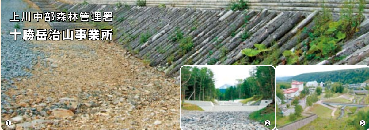
写真①景観に配慮しコンクリート堤体にカラマツを張った硫黄沢導流堤 ②土石流の勢いを弱める治山ダム群 ③治山施設群が守る十勝岳山麓の白金温泉街
