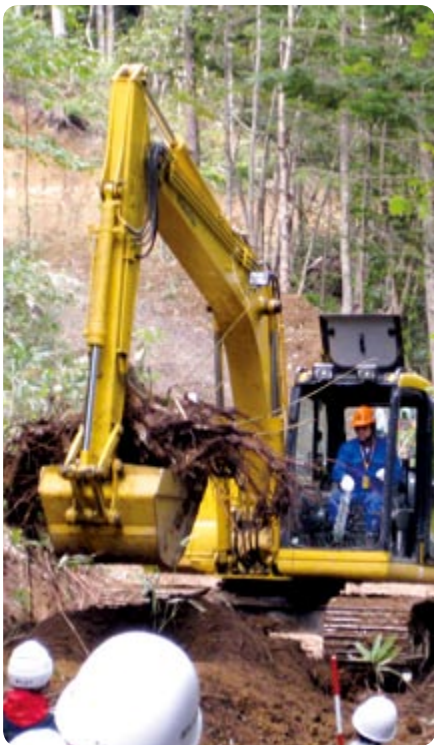
西置賜ふるさと森林組合の渡部氏による表土ブロック積み工法の作業実演
