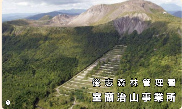
下流域の安全を図り、緑化を進める有珠山大平地区の低ダム群工法
