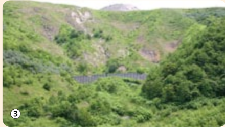
治山工事で緑が蘇った有珠山小有珠川地区
