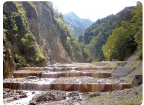
土石流災害から市街地を守る治山施設
