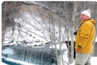
ダムの状況調査
