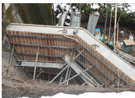
トドマツ型枠の使用状況
