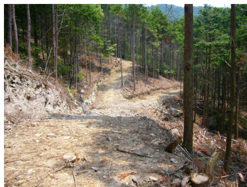
写真 3 (切土高を低く作設)
