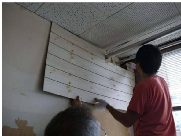
写真-8 壁の施工
