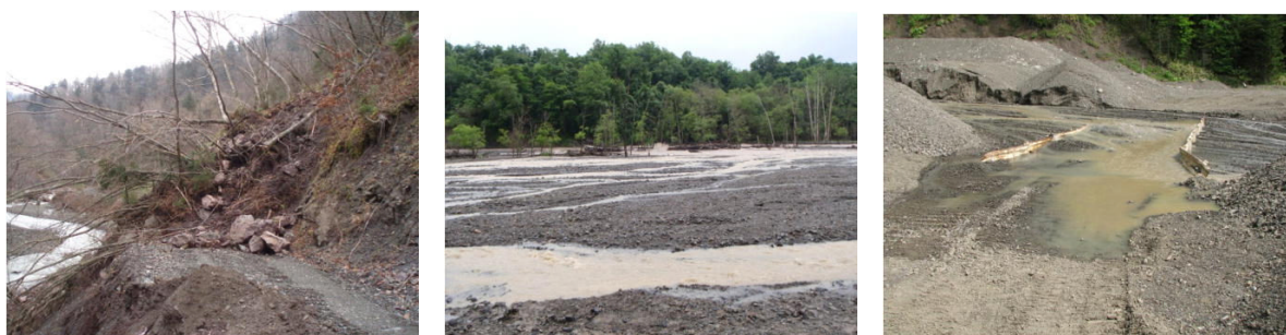
写真－3 被災パターン。左から「斜面崩壊」、「河道への土砂流入」、「土砂堆積」
