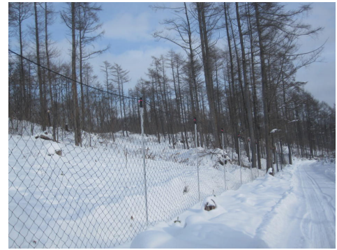
写真 7 エゾシカ侵入防止柵（千歳市）
