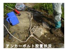
カーとロッククライミング用埋め込みボルト、及び薄い表 アンカー 土の下の凝灰岩に刺さる、太い径の鉄杭を使ってみることとしました。
