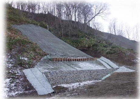
治山工事(山腹工)(渡島檜山森林計画区)
