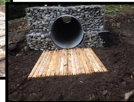
間伐材を利用した洗掘防止工
