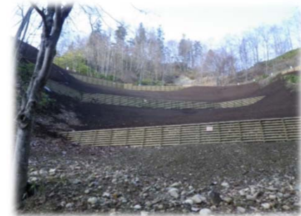
間伐材を利用した山腹工 (十勝森林計画区)
