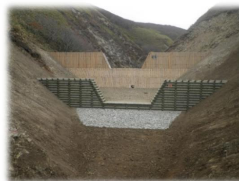
治山工事(校倉式木製ダム) (宗谷森林計画区)
