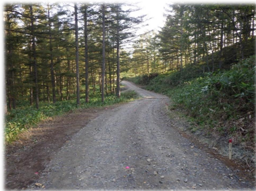
開設された林道(林業専用道) (胆振東部森林計画区)
