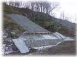
治山工事(山腹工)(渡島檜山森林計画区)
