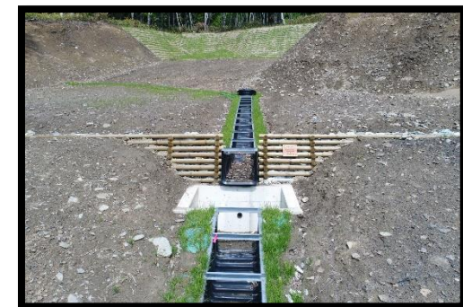
治山工事(木製校倉式土留工) (上川南部森林管理署管内)
