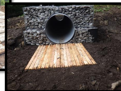
間伐材を利用した洗掘防止工 (上川南部森林管理署管内)
