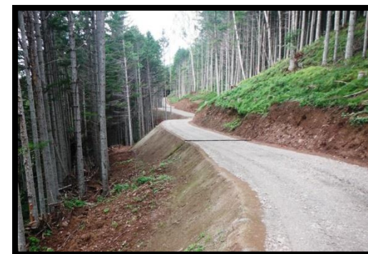
新設林道(林業専用道) (十勝東部森林管理署管内)
