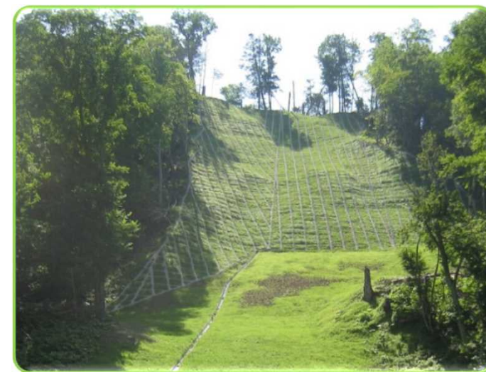
治山工事施工地 (根釧西部森林管理署管内)
