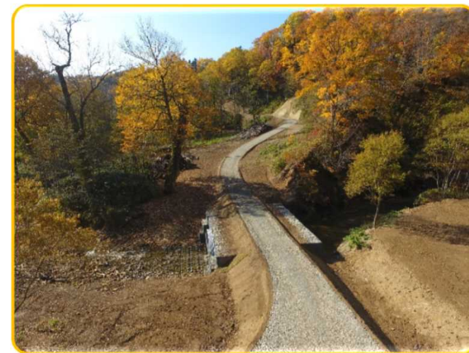
新設林道(林業専用道) (留萌北部森林管理署管内)
