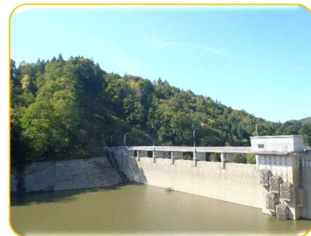
苦前ダム (留萌南部森林管理署管内)
