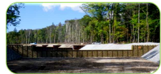
治山事業 溪間工(木製校倉式床固工) (胆振東部森林管理署管内)
