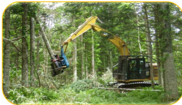
ハーベスタによる伐倒作業 (宗谷森林管理署管内)
