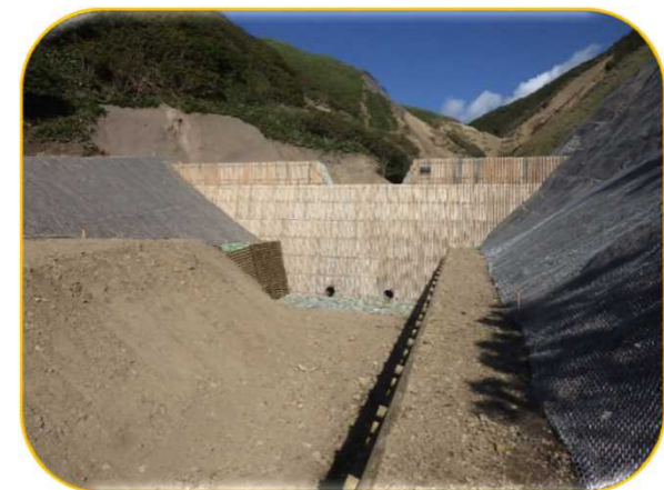
治山工事施行地 (宗谷森林管理署管内)
