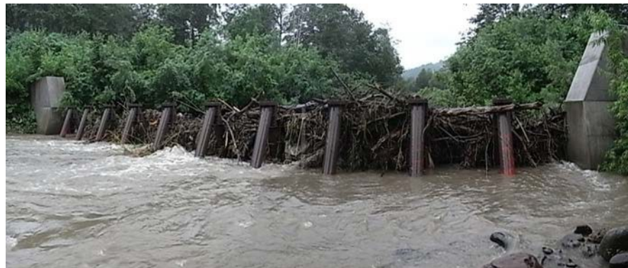
スリットダムによる流木対策 (幌加内町:空知森林管理署北空知支署管内)
