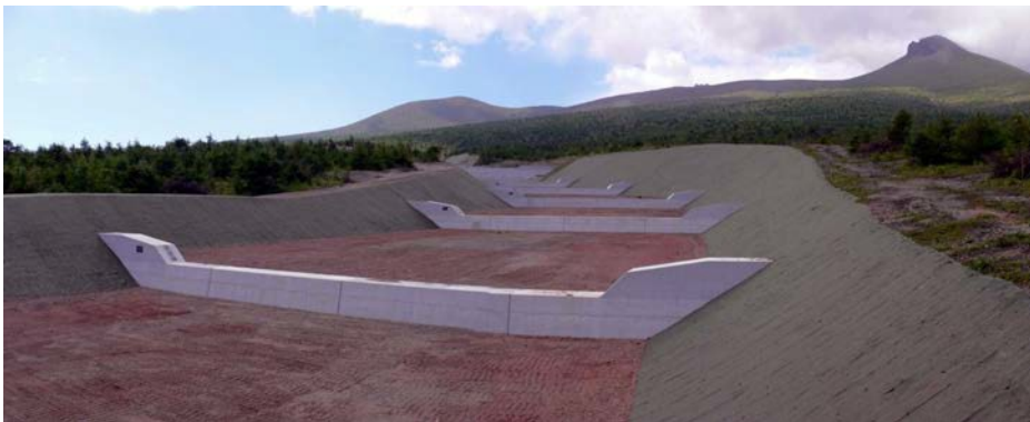
駒ヶ岳における治山事業による荒廃山地の復旧状況 (鹿部町:渡島森林管理署管内)
