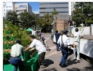
カミネッコンはトラックで運搬
