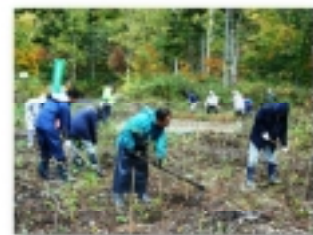
設置場所の地ならし作業
