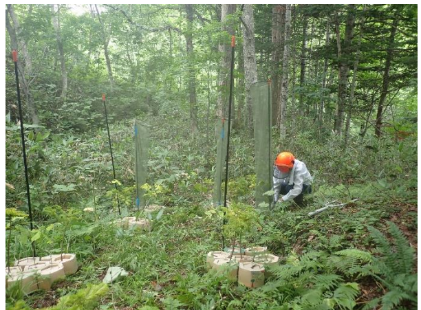
[防鹿ネット設置の様子]
