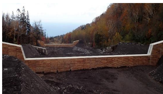
間伐材を使用した丸太残存型枠【治山工事】
