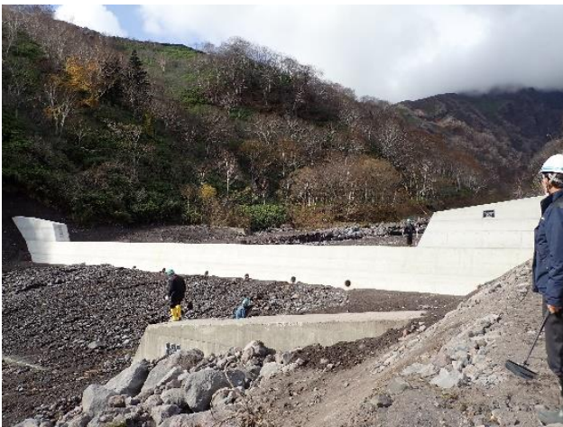
ヤムナイ沢治山工事（利尻富士町）
