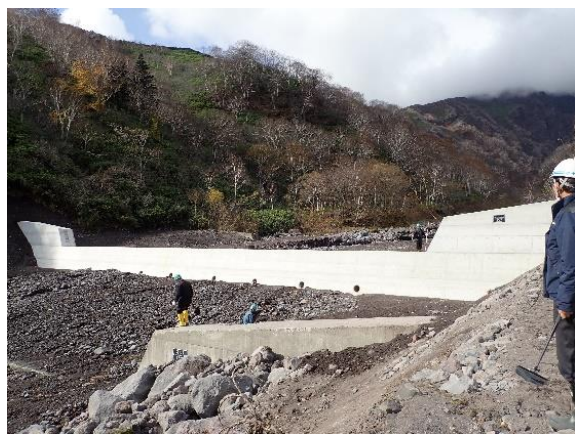
ヤムナイ沢治山工事（利尻富士町）
