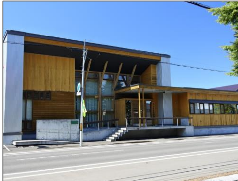
木造建築の庁舎 (構造材には、カラマツ・トドマツ・エゾマツの大断面集成材を使用)
