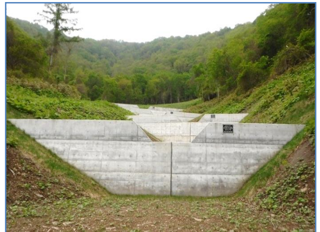
だて 土砂災害を防止する治山ダム（伊達地区）
