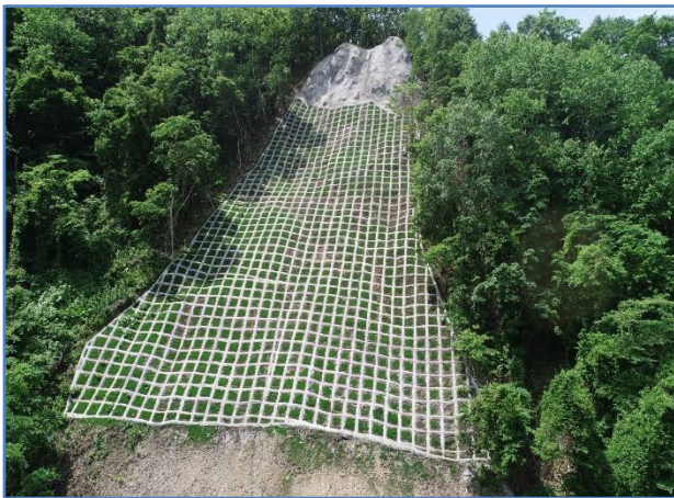
だて 山腹崩壊の拡大を防ぐ簡易法砕工（伊達地区）
