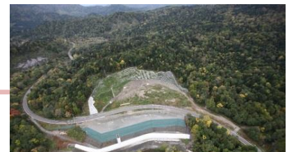
霧立地区災害復旧 (苫前町)
