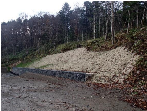
護岸工・山腹工 (小平町)
