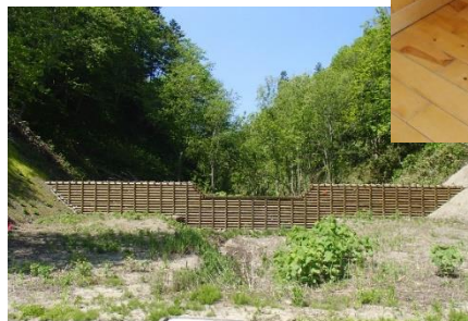
トドマツ間伐材を使用した治山ダム
