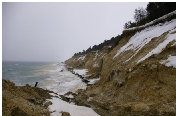
(崩落地：施工前)
