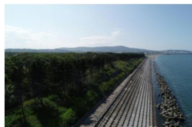
(傾斜護岸工の施工箇所)
