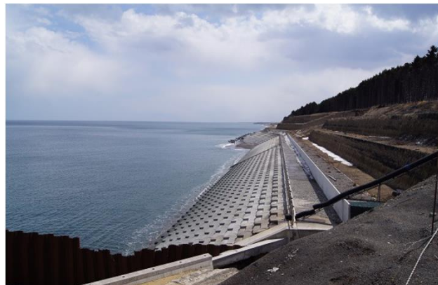
(崩落地：施工後)
