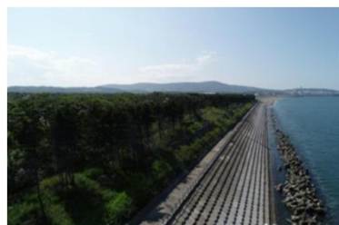
(傾斜護岸工の施工箇所)
