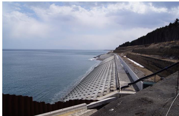
(崩落地：施工後)
