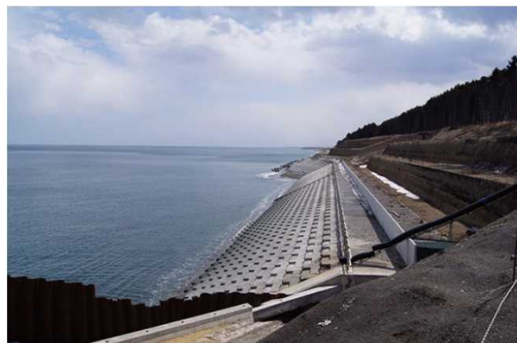
(崩落地：施工後)
