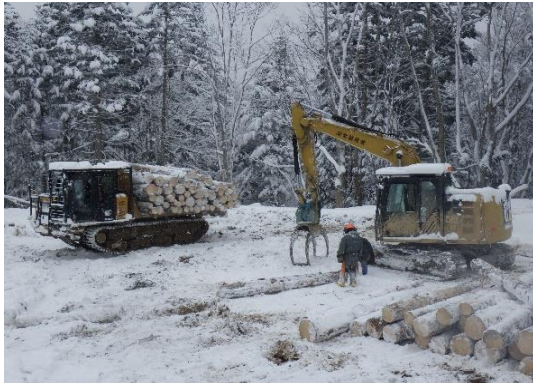
生産された丸太の仕分け作業
