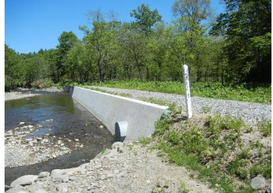
災害復旧工事 （幌加内町上石油沢林道）
