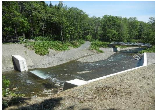
治山事業によるコンクリート床固工 （幌加内町雨煙別）
