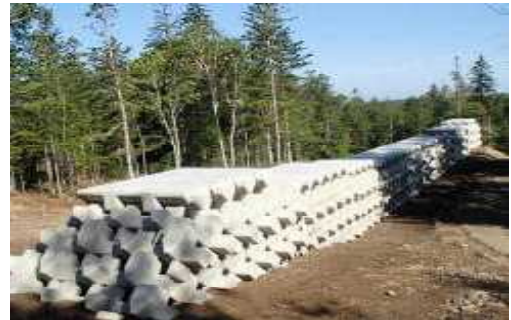
ブロック導流堤 十勝岳(美瑛町)
