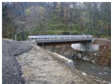
八線沢林道改良工事(橋梁) (愛別町)
