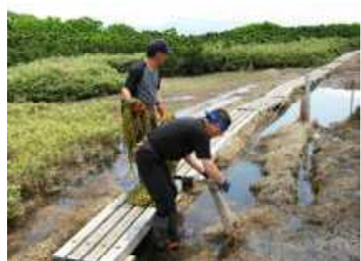
木道の補修・ロープ張り
