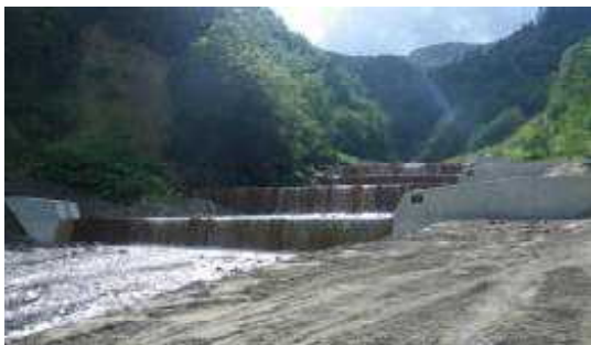
床固工 黒岳沢(上川町)
