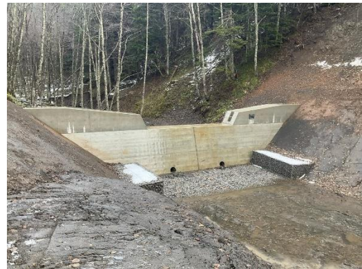
ホテイ沢 1 号治山工事
