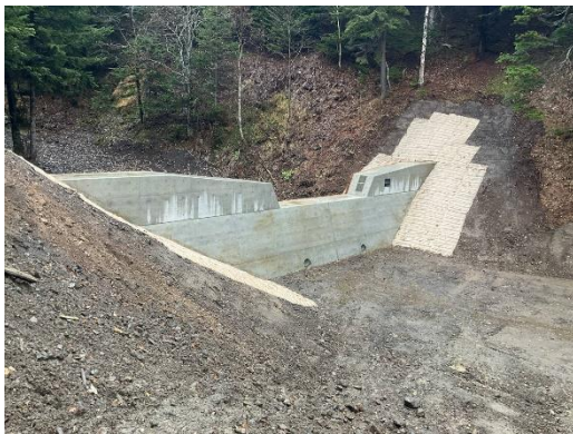
サマンペテイネ沢 2 号治山工事
