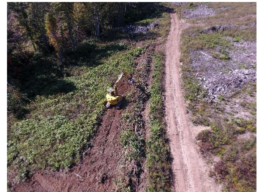
「表土戻し地拵」による天然更新補助作業 (美瑛町国有林)
