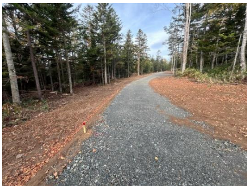
白金大曲林道新設工事
