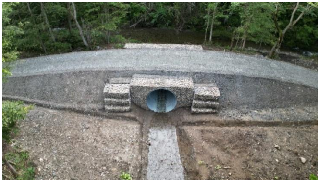
雨紛林道改良工事
