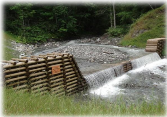
景観に配慮した治山ダム(富良野)
