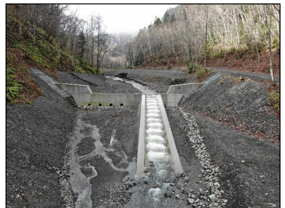
既設の治山ダムに魚道を設置
